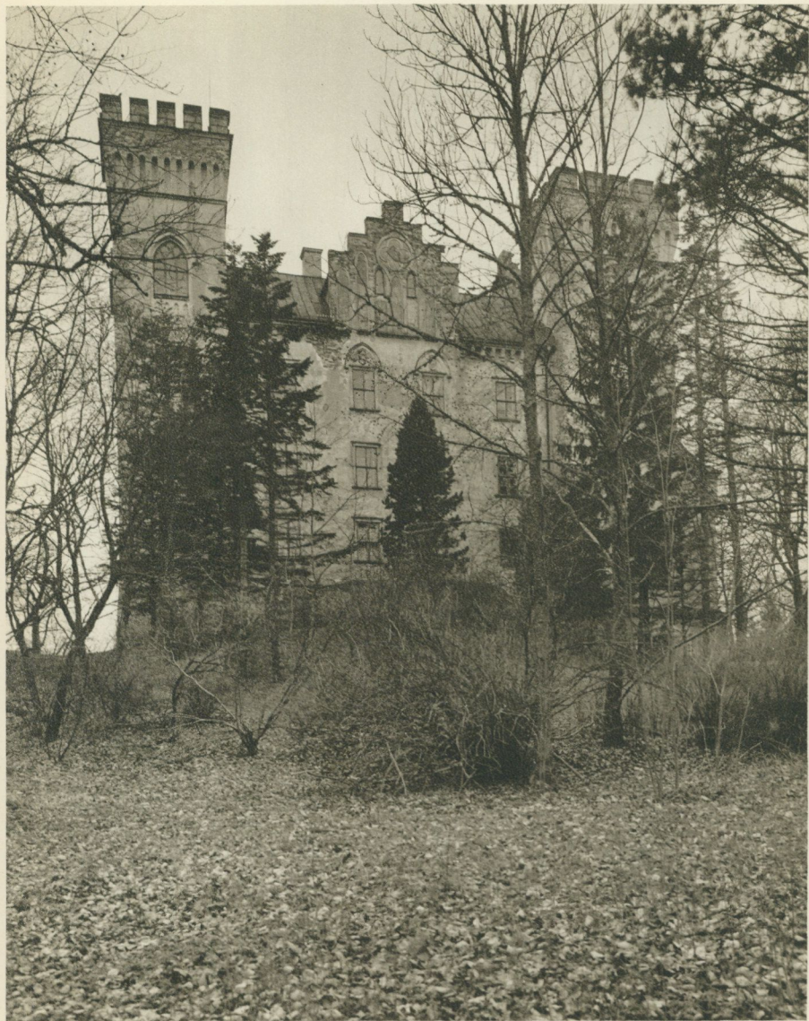
Bild 11. Bogesunds slott, östra fasaden.
