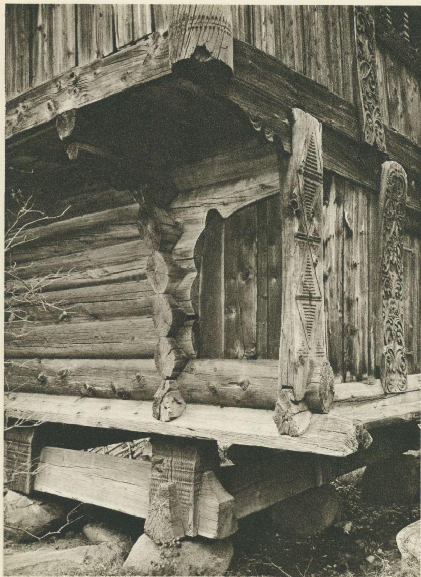
Bilde 5. Et hjørne av Vastveitloftet som viser tømringen og utformingen av den opprinnelige åpne sval.
