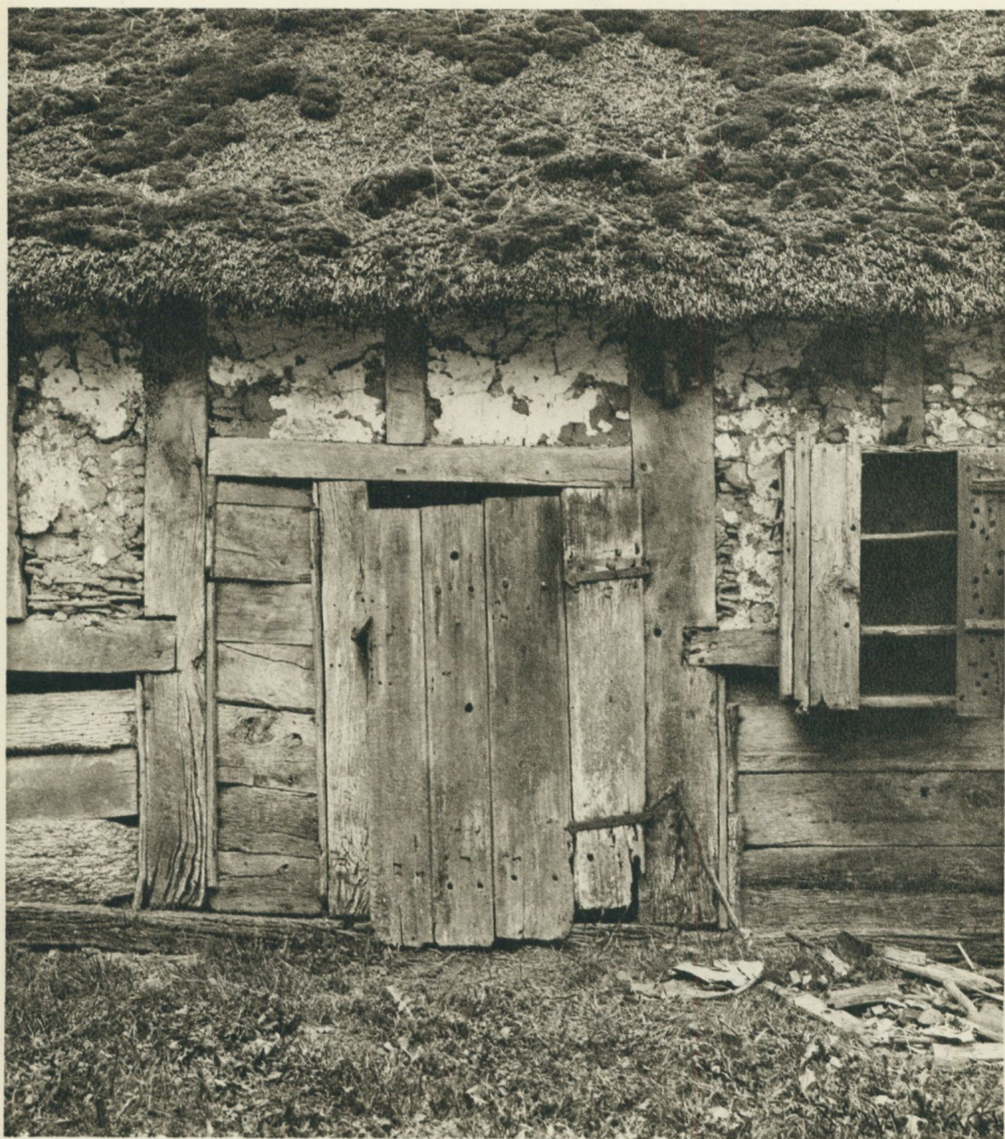
Ravlundagården före flyttningen till Skansen. Parti av portlängans gårdsvägg, byggd delvis i korsvirke, delvis i skiftesverk med lig- gande ekplank. Dörren leder till häststallets fodergång. Till höger på väggen en osthäck.
