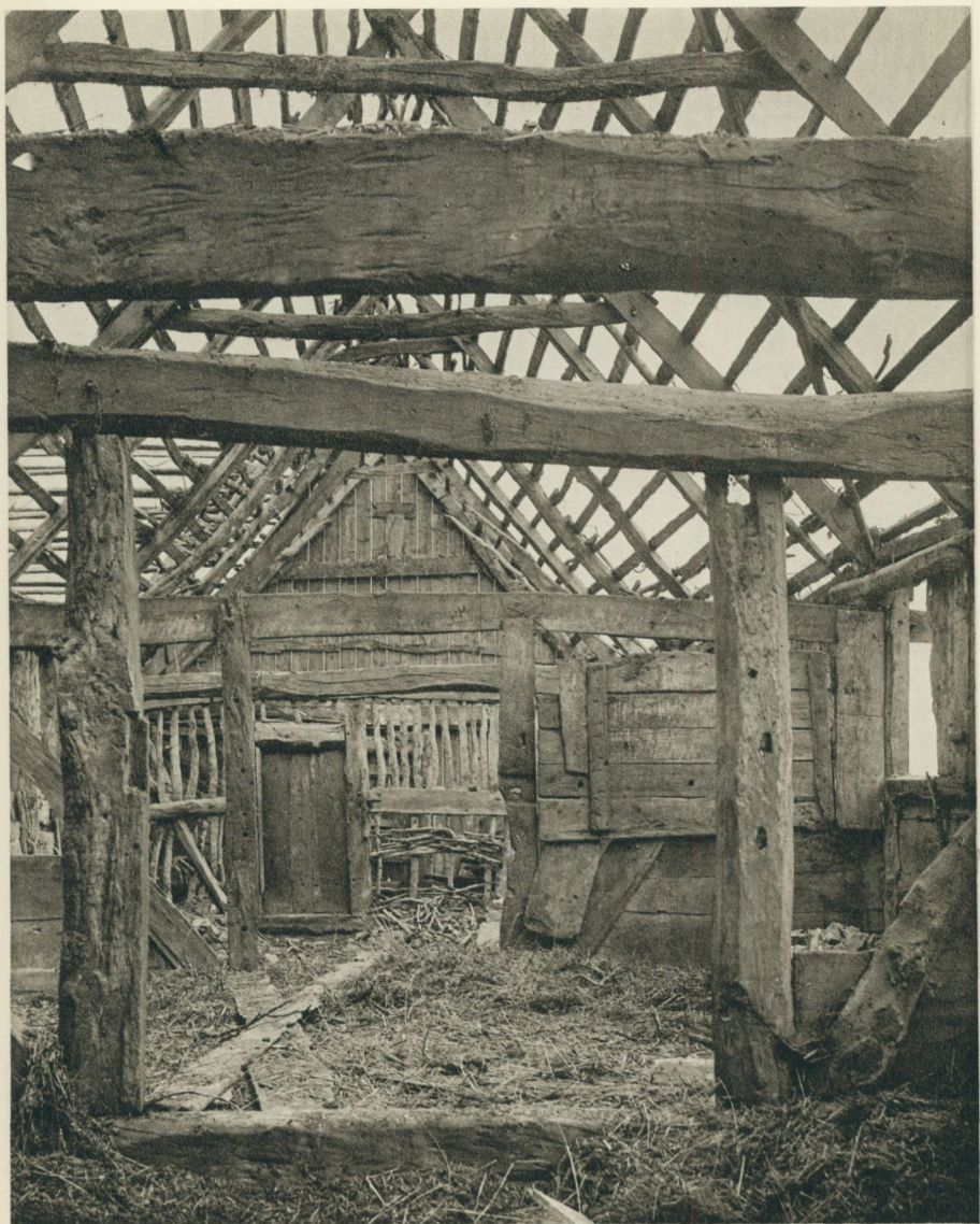
Interiör från samma länga. I väggen till kostallet har lerklining avlägsnats från stakarna.
