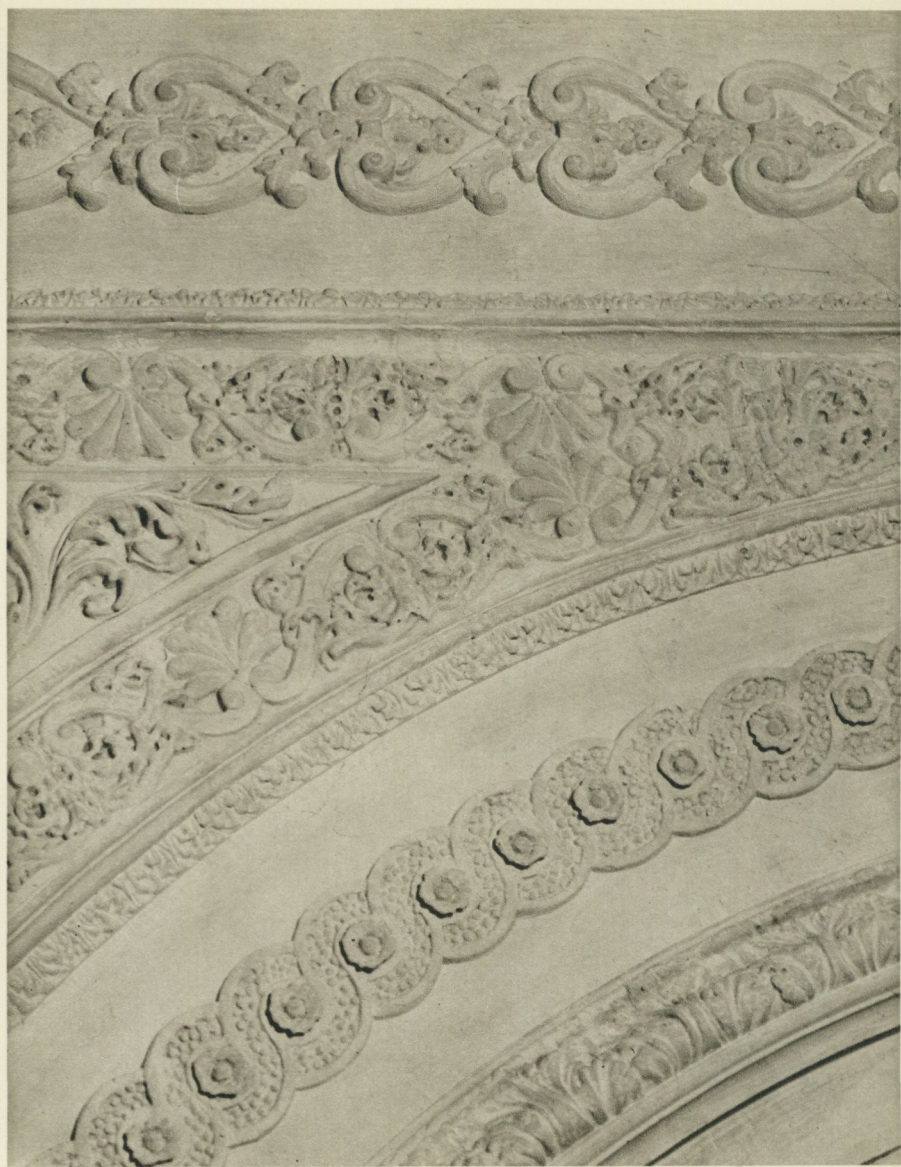
Bild. 2. En detaljbild av samma stucktak visar de i formär gjutna ornamentbårderna.
