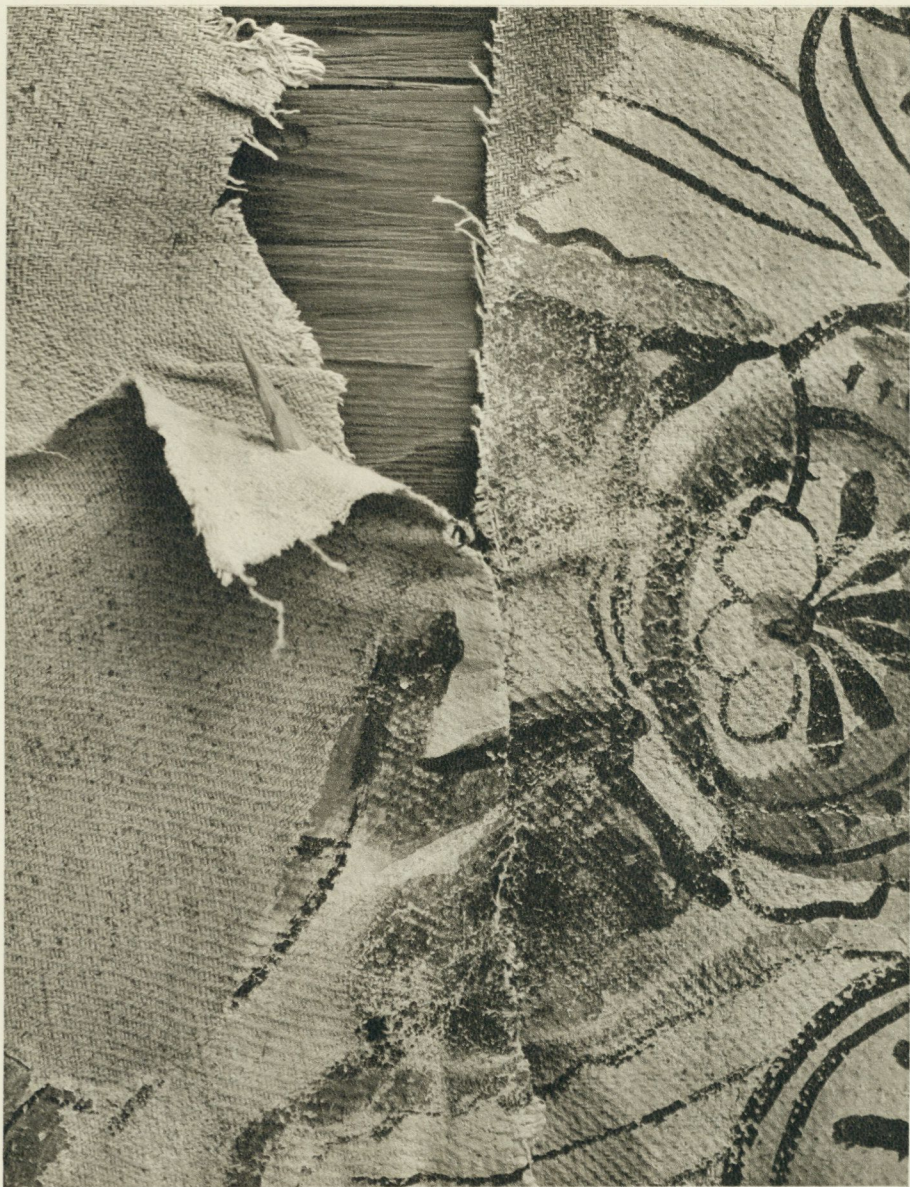
Bild 3. Pluggar av en eller gran användes när vävunderlaget till dalmålningen fästes på timmerväggen.
