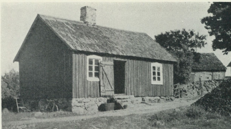
Gelbgjutarverkstad vid Loshult 1 5 , byggd 1898. Till vänster om dörren är "gjuthuset", till höger verkstaden. I grunden på ömse sidor om trappan ses mynningarna till två av härdens lufttrummor.
