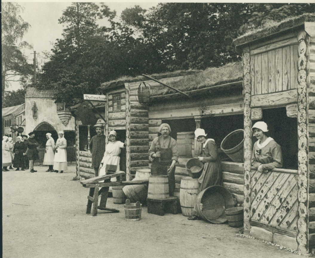
Gatubild från Skråtuna med tunnbindareverkstad.
