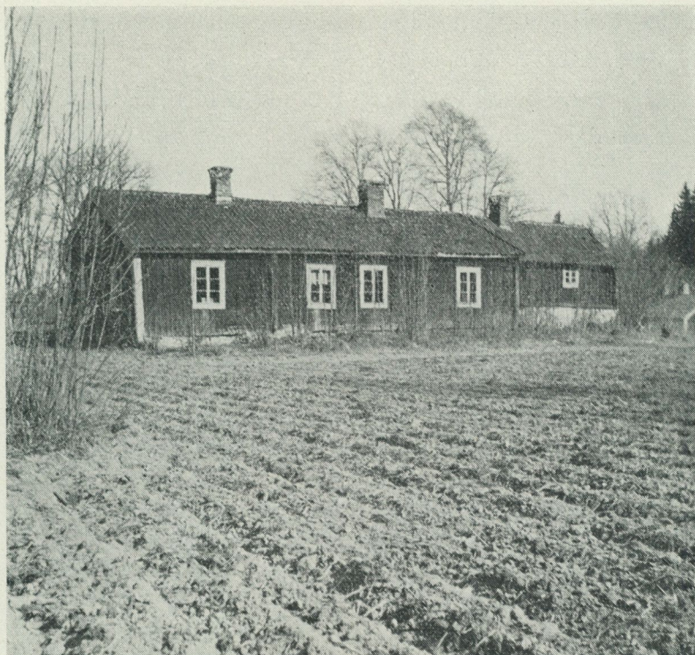
Prästgården Lilla Forssa vid Mönsterås, där Jacob Wallenberg verkade som kyrkoherde 1777—1778. Byggnaden uppfördes 1728 och användes av Wallenberg som gästflygel; själv bodde han i en senare uppförd och nu riven huvudbyggnad på gården. Foto Manne Hofrén 1947.
