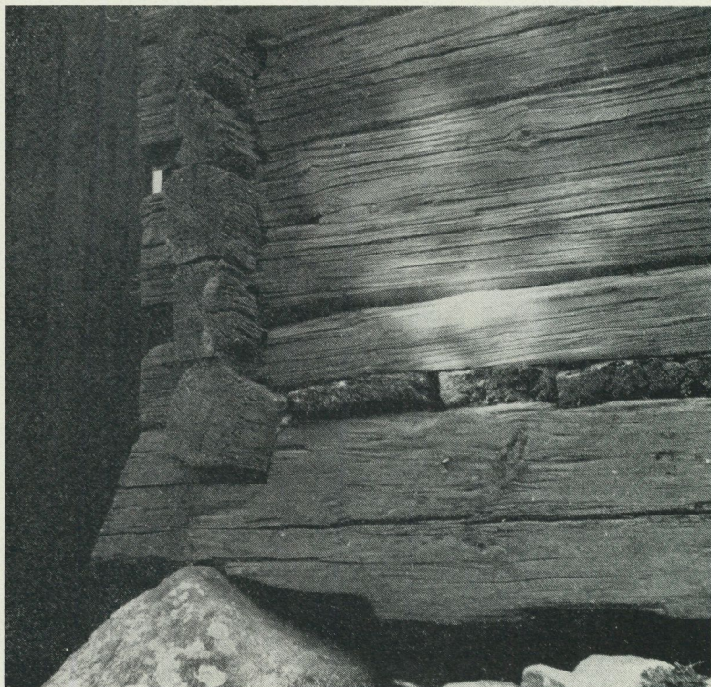
Syllen vid västra knutkedjan. S. k. dubbelkatt i knutkedjan med snedhak i knutskåran. Observera golvbräderna, som vilar på syllen; de är halvklovor, runda undertill, men avfasade där de vilar på syllen. Foto 1957 Ingalill Granlund.
