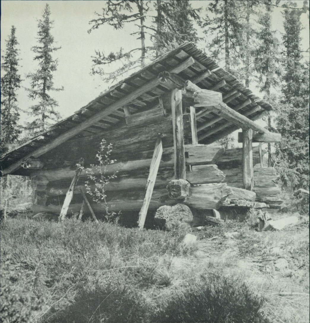
Slätterbod i Rackdalen vid Tjytjysbäcken, daterad 1720. Förtaket har fallit ner.
