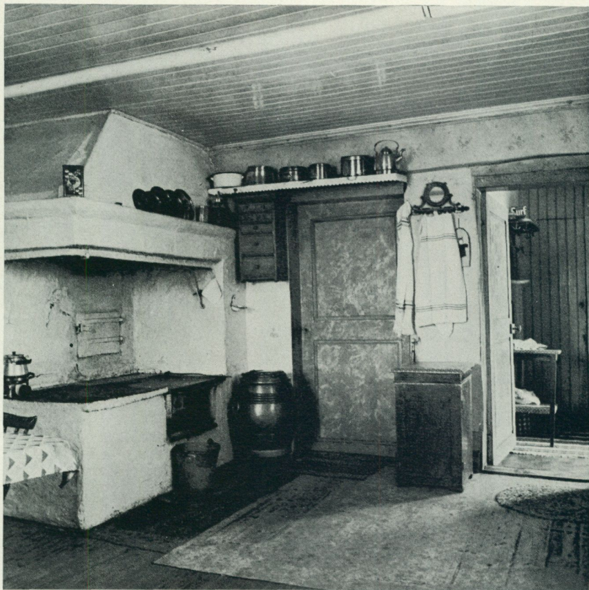
4. Köket i ett dagsverkstorp i Uppland 1967. Ägaren bosatte sig här 1902 och skaffade under de första åren kopparvattentunna, kryddskåp, kommod, paradhandduk med hängare, m.m. Väggarna var klädda med pärlspånt, »rävskinn», som senare täckts med papp och tapeter men ännu syns t. h. i farstun. Många kök såg ut så här både före, under och efter 1920-talet.
