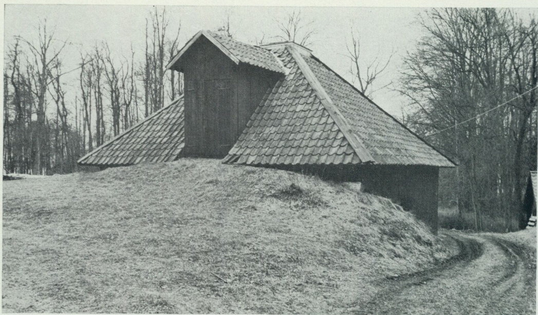
9. Kalkugnen på Julita gård från öster. Ugnen har beskickats genom en öppning överst på denna sida. Träsigt virke och tegel har utbytts, murverk och puts har lagats, nockbråder cuprinolats, plåtskoningar utbytts. Foto J. Å.
