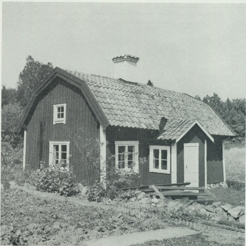
16. Tak, ytterpanel och skorsten är reparerade, grunden är dränerad. Huset, liksom anlägg- ningens övriga byggnader, avfärgat i Falu rödfärg. Dörr- och fönster- foder vitmålad. Vissa skyddande plåtskoningar ut- förda över in- gången. Foto J. A. 1973.
