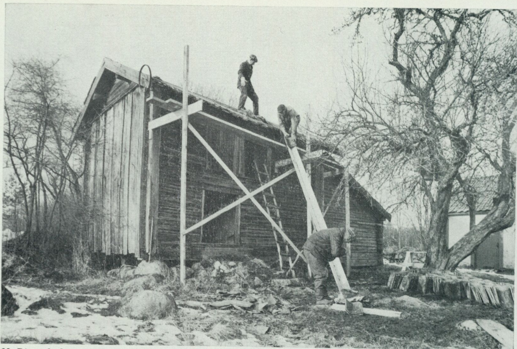
25. Djupanboda. 1600-talsloftboden under pågående reparation. Smärre partier av väggar och golv var starkt fuktskadade och har utbytt. Taket är omlagt. På den gamla panelen av mycket breda bi- lade plankor har lagts ett skikt korrugerad alumi- niumplåt. På detta lägt och tegel som tidigare.
