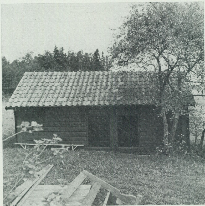
19. Lövhagen. Visthusboden sedan den stagats upp och brädpanelen på takets försetts med skyddande korru- gerad aluminium- plåt och oljehär- dad masonite under tegeltaket. Maso- niten endast en smal remsa närmast takfoten, där plåten annars skulle blänt fram. Foto J. A. 1973.
