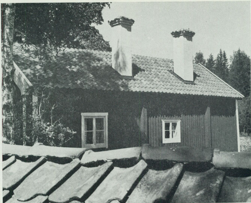
27. Förarstugan med sina karak- täristiska höga skorstenar återupp- murade sedan taket belagts med maso- nite under tegel- taket. Taket i förgrunden hör till en bevarad liten källarbyggnad som också reparerats. Foto J. A. 1973.
