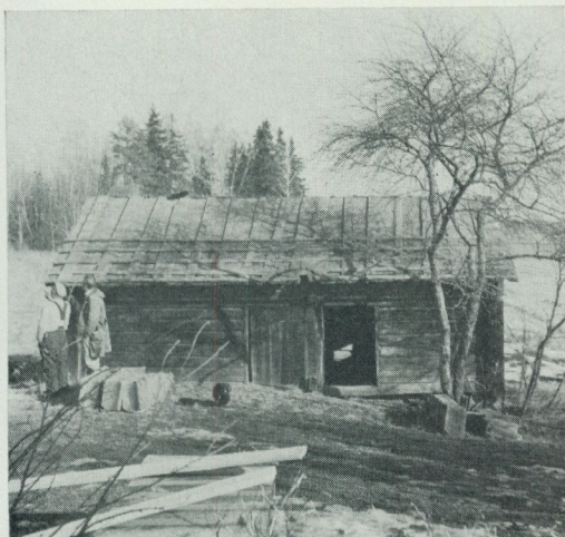
17—18. Lövhagen. T. v.: Visthusboden under reparation. T.h.: Den gamla visthusboden lyfts med domkraft efter att i många år stått kanträd mot Löten. Foto J. A. 1973.
