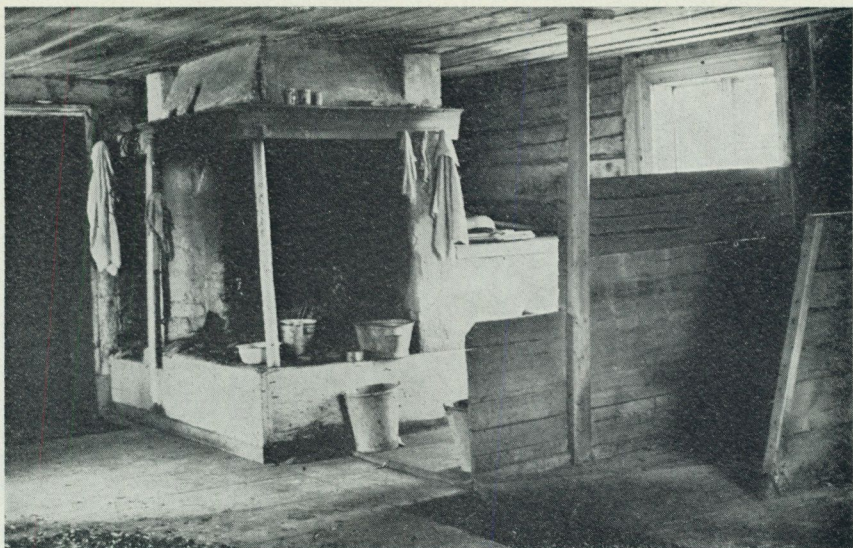
3. Interiör av fähus med eldstadskomplexet vid dörren. Fähuset är sammanbyggt med ett bostadsrum, som när bilden togs användes av tjänstefolk. Norrbergs by, Delsbo socken, Hälsingland. Foto Sigfrid Svensson 1938.
