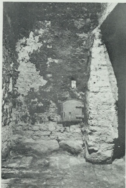
13—14. Hög 18:1. I Boningshuset finns den gamla skorstensstocken kvar, vars nedre del utgjort gårdens ursprungliga kök. Spåren efter den borttagna bakugnen är så tydliga att den kan rekonstrueras. Luckan, genom vilken biläggargugnen i stugan eldades, finns ännu kvar. Foto 1974.
