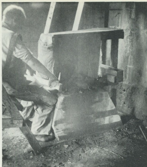
19. Då bladet skall slipas, läggs det i ett slipträ med inskränning för lieegen.
