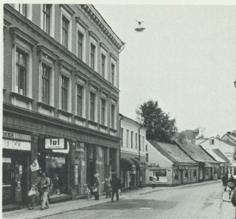
Djärvheten i byggnadstekniken stegrades successivt kring 1800-talets mitt. I fonden gammal korsvirkensbebyggelse i en våning men med utvändigt tegelkomplettering. Närmare hitåt en enkel tvåvåningskonstruktion och i förgrunden ett typiskt exempel på borgerlig hyresbebyggelse i genomförd klassicistisk dräkt med 1½ stens bärande tegelstomme och tunga träbjälklag. Gata i Lund. Foto förf. 1982.
