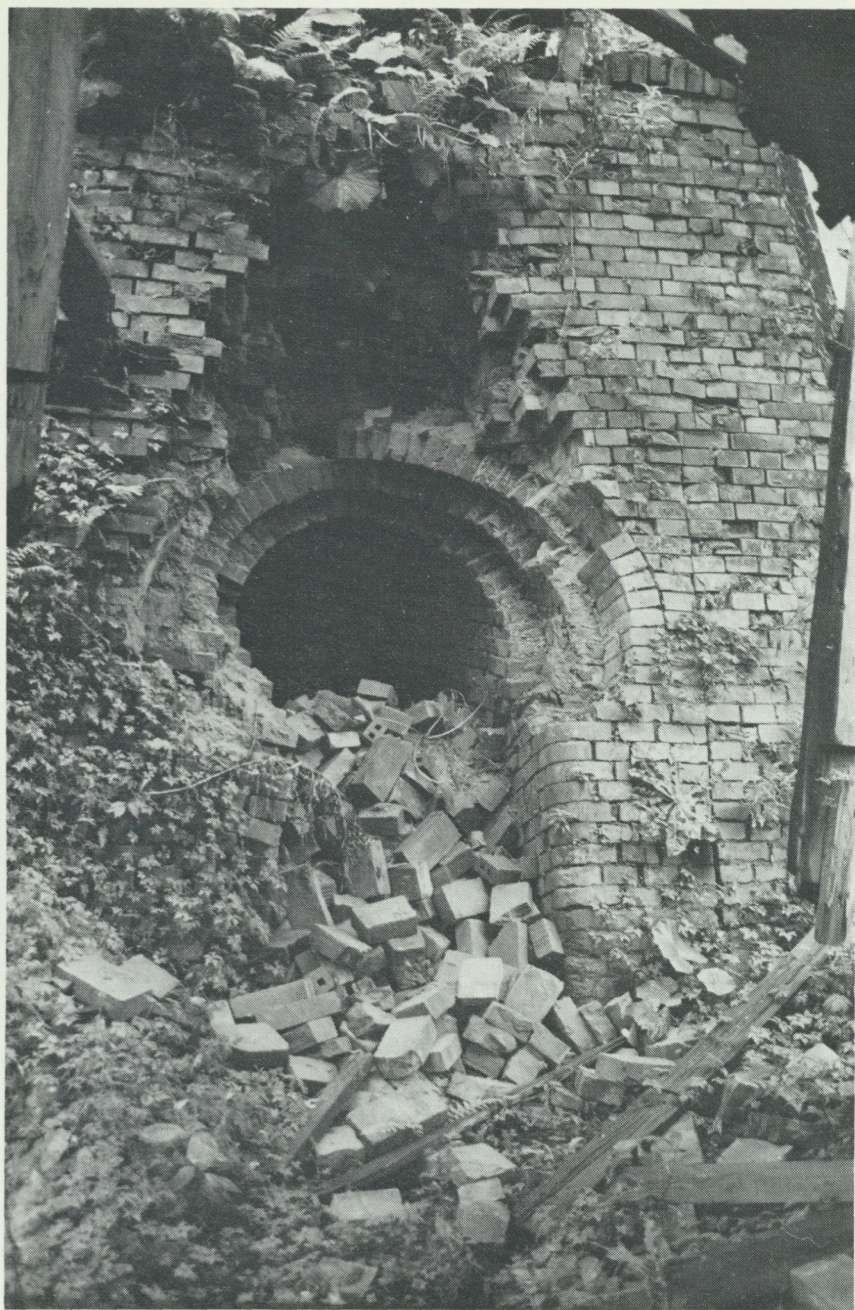
En tyst förintelse pågår av de sista resterna från den skånska tegelproduktionens storhetstid. Sammanstörtande partier av Yddinges stora ringugn. Foto förf. 1982.
