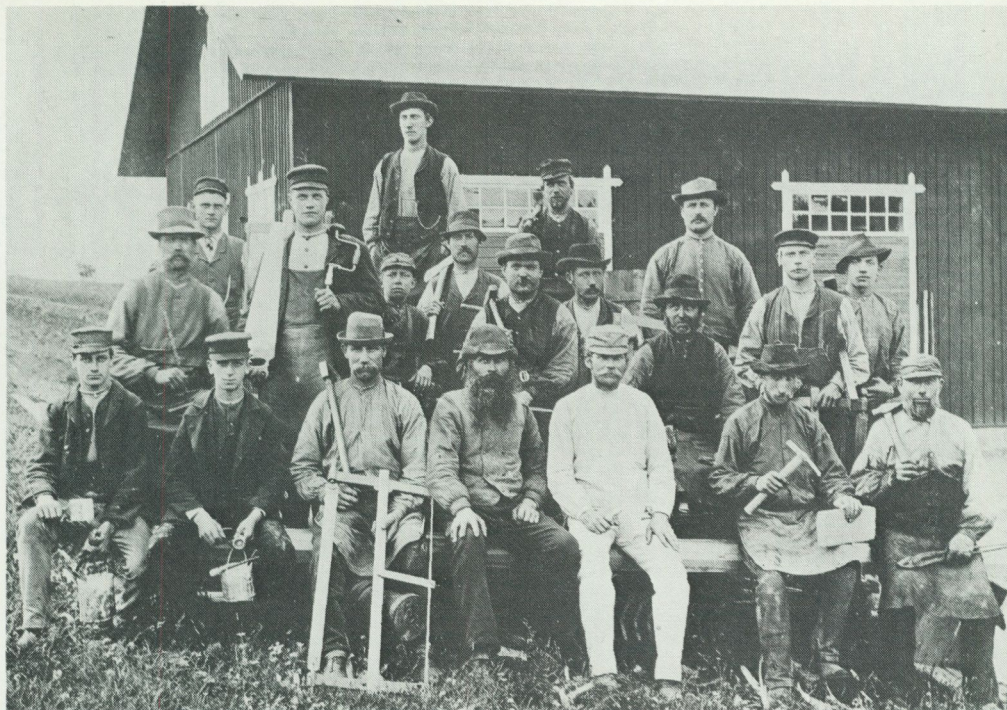
Arbetslag med timmermän, murare, målare och en smed. Bilden togs 1906 i samband med uppförandet av spelhus till Vasaschaktet i Dalkarlsberg utanför Nora. Foto Hembygdsföreningen Noraskogs bildarkiv.
