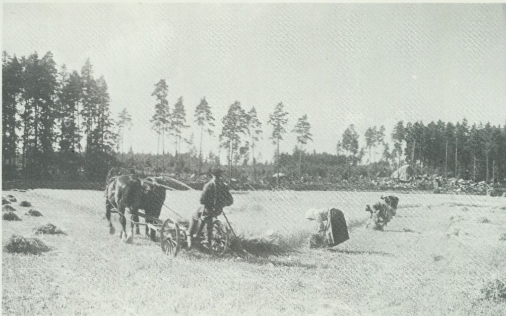
11. Slättermaskinen utgjorde det första steget på skördens mekanisering. Det gällde att minska arbetsåtgången under denna årets arbetstopp. Lånen kunde nu ställas åt sidan, men säden måste fortfarande bindas till kärvar så fort den slagits. Från Länna socken i Södermanland 1926. Foto D Samuelson.
