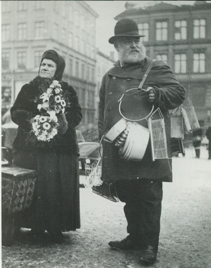
Två försäljare på Hötorget i Stockholm 1904. Mannen säljer bleckkärl och ståltrådsarbeten som råttfällor och strykjärnsställ. Foto Erik Tryggelin.
