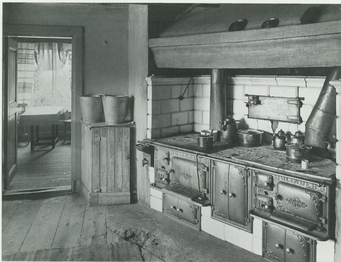
De nya järnspisarna byggdes in på platsen för den tidigare öppna härden, oftast med det gamla rökfånget, spiskupan, och bakugnen kvar. Kockärten måste också anpassas efter de nya spisarna. Foto omkring 1900.
