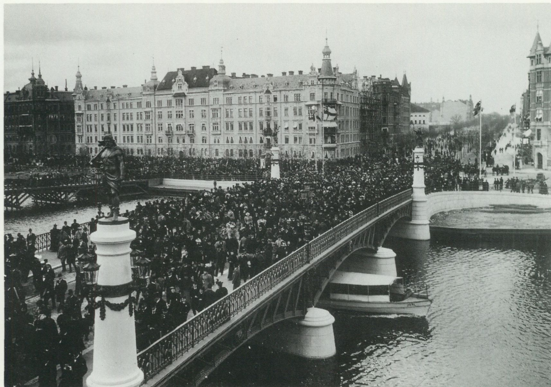
Den nya Djurgårdsbron hade invigts redan den 10 maj. Öppningsdagens folkmyller på Strandvägen och Djurgårdsbron. Foto Axel Lindahl.
