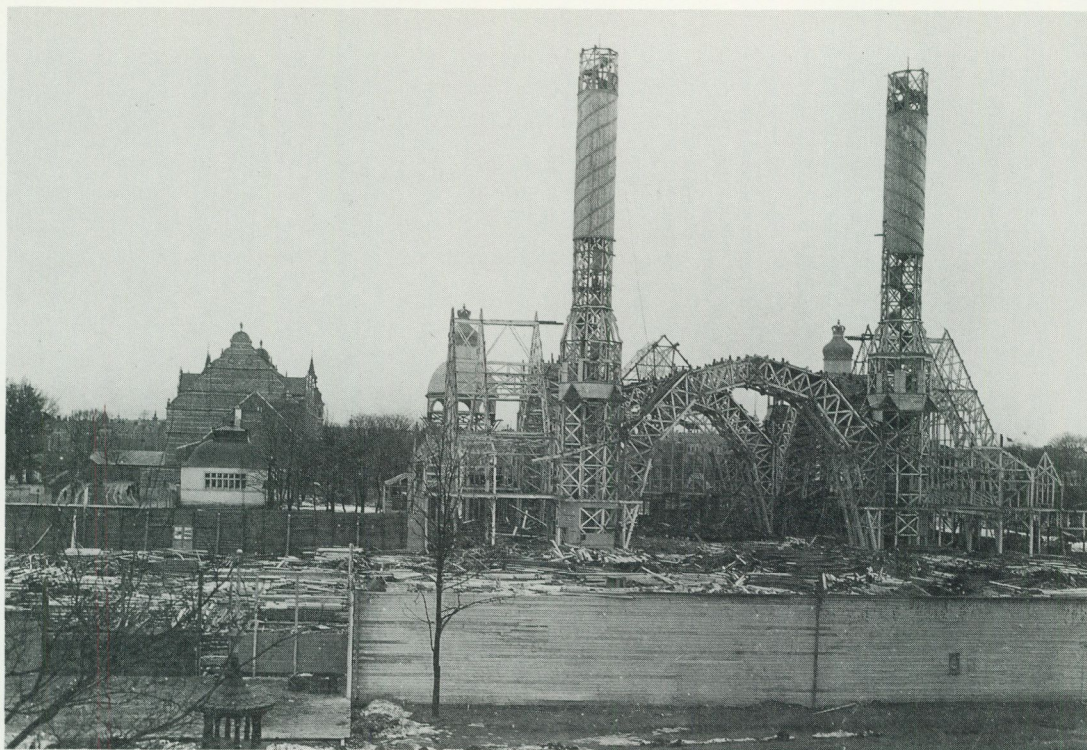
Den 3 oktober stängdes utställningens portar och den hade då besökts av 1,2 miljoner besökare på fyra och en halv månad. I april 1898 hade rivningen av Industrihallen kommit så här långt. Foto i Stockholms Stadsmuseum.
