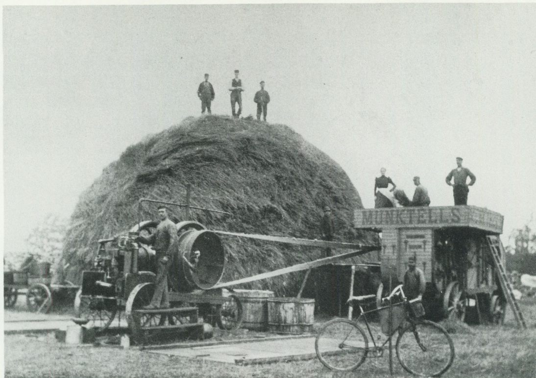
De lokomobildrivna tröskverken med mekaniserad rensning av säden sparade arbetskraft. "Munktells" med fotogendriven motor i Näsby, Ås socken på Öland 1901.
