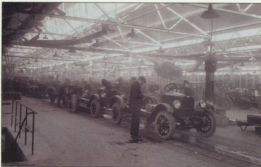
GMS monteringsfabrik i Hammarbyhamnen, Stockholm, 1930-tal. FOTO: FRIBERG.
