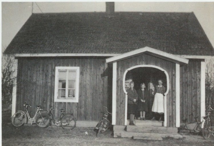
Ingrid Dahl från klass 3 i Sörvattnets mindre skola i Härjedalen ses här med syster och mamma på brokvisten till sitt hem. Bostaden har två rum och kök samt en vinds-kammare. Foto Nordiska museet.
