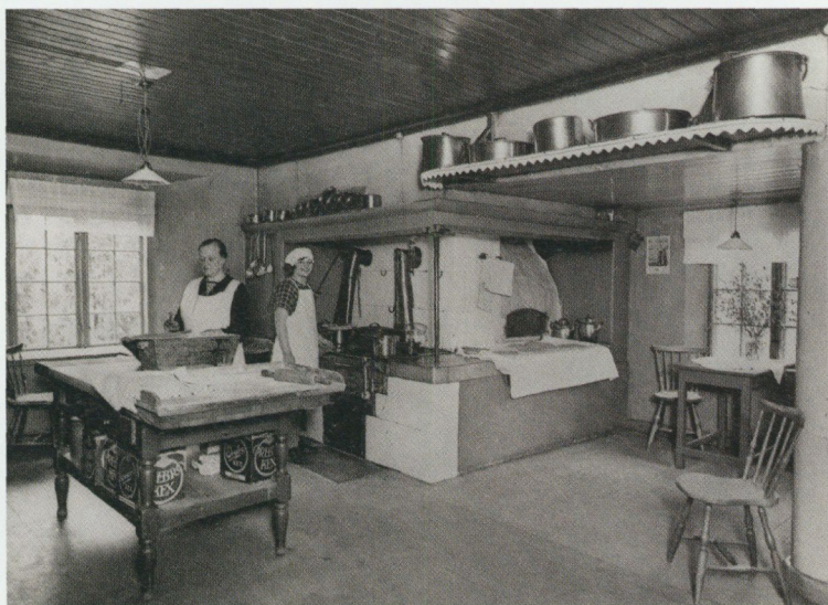
Köket i södra flygeln ca 1931. Här fanns både vattenledning och elektriskt ljus sen ett tiotal år. Foto Bertil Norberg, Nordiska museet.
