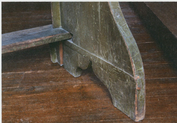
Undersidan av brudstolens ena gavel. Fotbrädans anslutning till den gavel som inte syns på bilden har snickaren löst på annat sätt. Det hela ger ett improviserat, rent av hafsigt, intryck, som står i stark kontrast till det omsorgsfullt komponerade och genomförda måleriet. Foto Peter Segemark, Nordiska museet.
