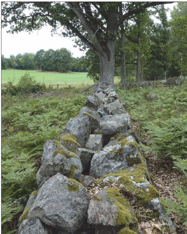
Figur 42. Stenmur av skalmurstyp. Materialet utgörs av sprängsten. Lägg märke till den trapetsoida formen. Muren står i ägogränsen mellan Nybble och Julita gårds Djurgårdshage. Foto från söder: Alf Ericsson.
